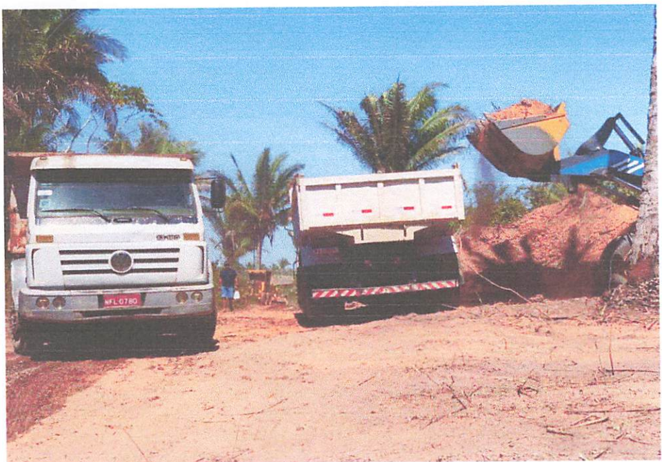
PIÇARRA DE JAZIDA PARA BASE DE PAVIMENTAÇÃO
